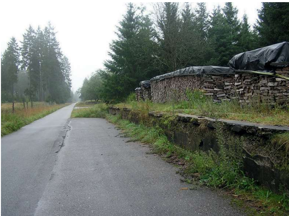
Herover resterne af de høje betonfundamenter, hvor de centrale bygninger for modtagelse af ammunition har stået.
