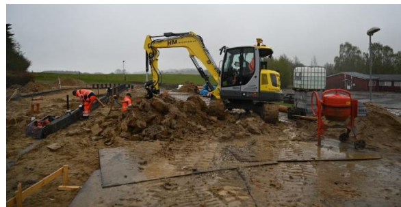
Entreprenørmaskinerne er i fuld gang
